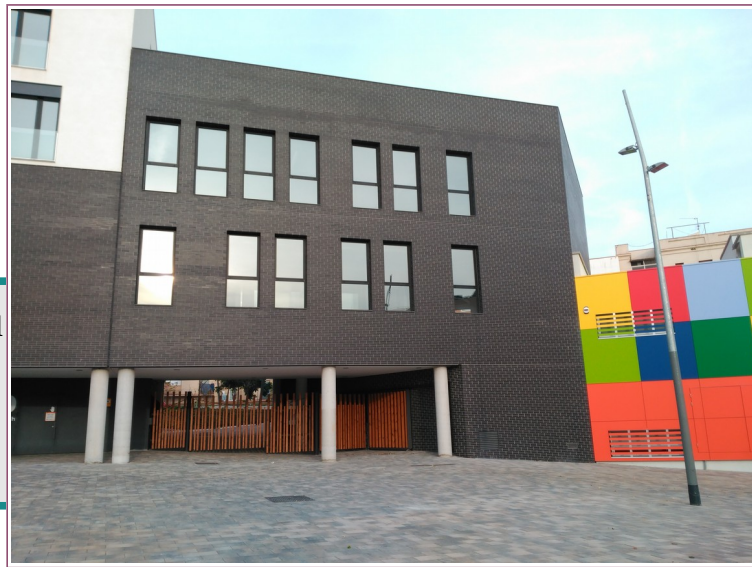
Vista de la façana del Casal de Joves del Guinardó des del Carrer Teodor Llorente
